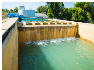
水処理プラント
